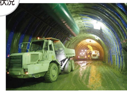
トンネル掘削状況
