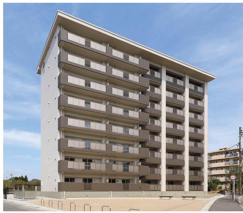
駐輪場 建物出入口スロープ
