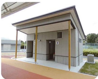
■屋外トイレ（新築）
