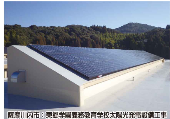
薩摩川内市：東郷学園義務教育学校太陽光発電設備工事
