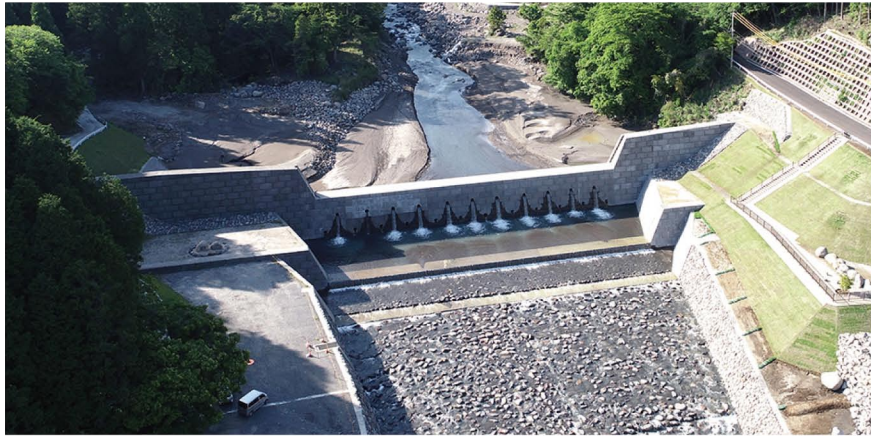
【10号堰堤】 堤高(8.5m) 堤長(128m) 貯砂量(約2万7000m³) 完成(平成30年2月)
