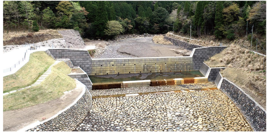
【11号堰堤】 堤高(10m) 堤長(97.5m) 貯砂量(約3万8000m³) 完成(令和3年12月)
