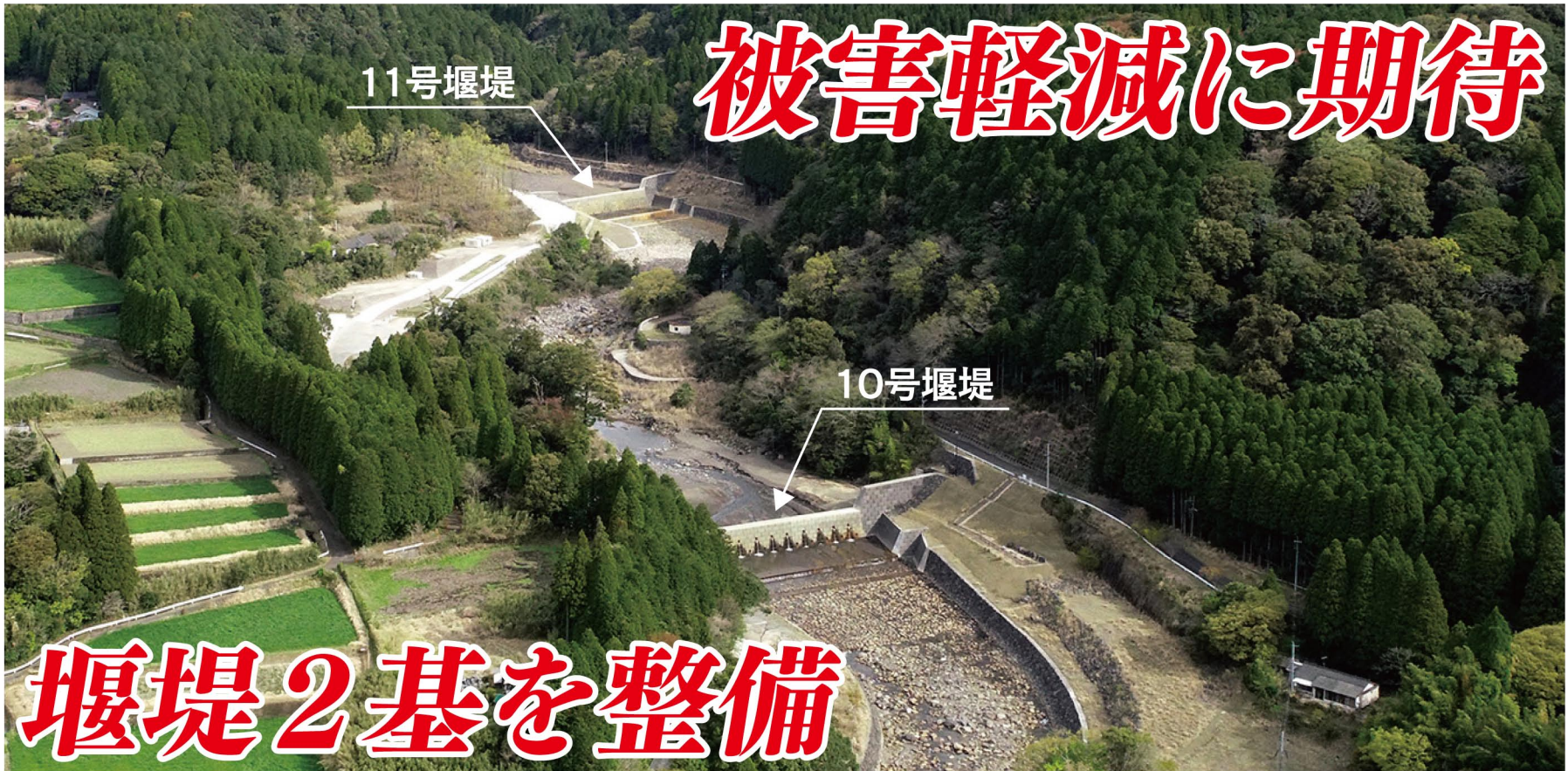
【10号堰堤】 堤高(8.5m) 堤長(128m) 貯砂量(約2万7000m³) 完成(平成30年2月)
