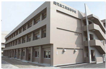
鹿児島工業高校校舎改築(5期)工事 がこのほど完成した。 新校舎は2020年 度から21年度の2カ 年で整備し、建物規 模はRC造3階建3 930㎡。
