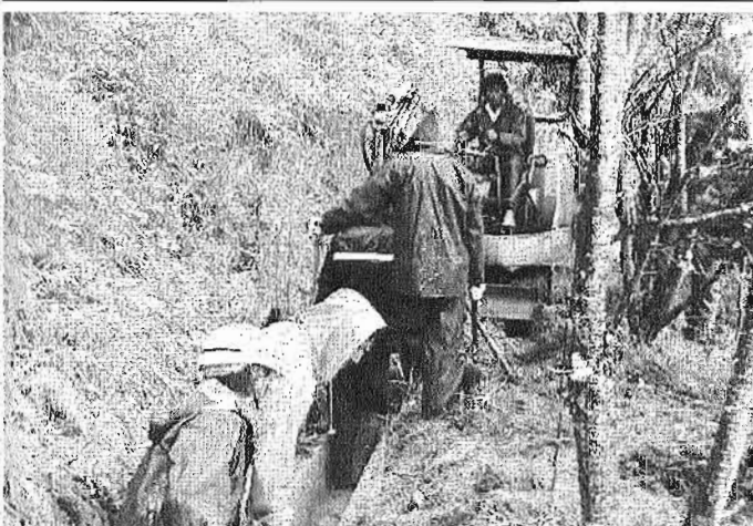
雨の中、側溝の土砂を取り除く参加者 ＝菱刈町の現地で
