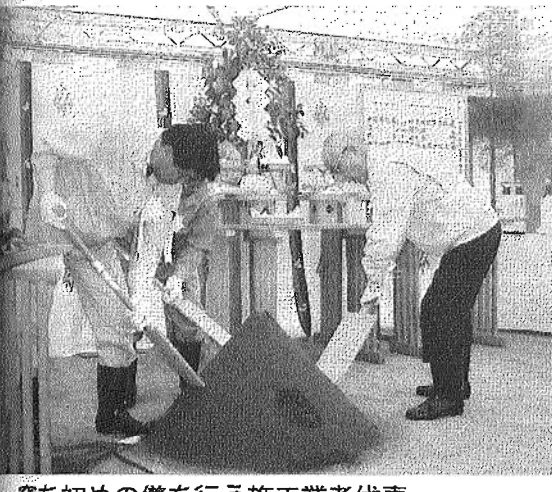
穿ち初めの儀を行う施工業者代表 =名瀬市伊津部町側坑口前で
