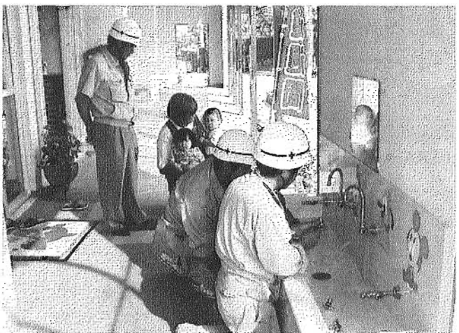
洗面所の点検・取替作業を行う参加者 ＝川内市の勝目保育園で
