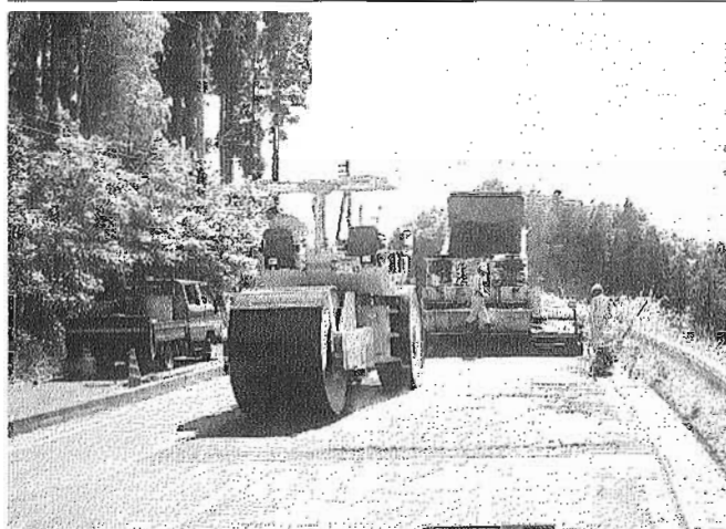
美しく仕上がっていく道路舗装 ＝溝辺町の現地で
