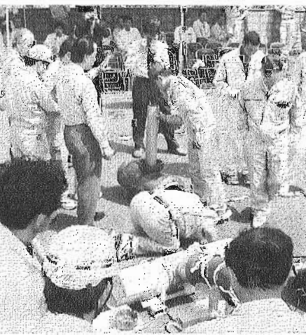
模擬管に施工された補修材を確認する参加者＝鹿児島市の鹿児島食品雑貨流通センターで
