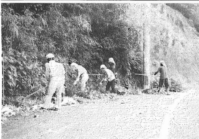
草払い等に汗を流す社員ら ＝鹿児島市伊敷町の甲突川右岸で
