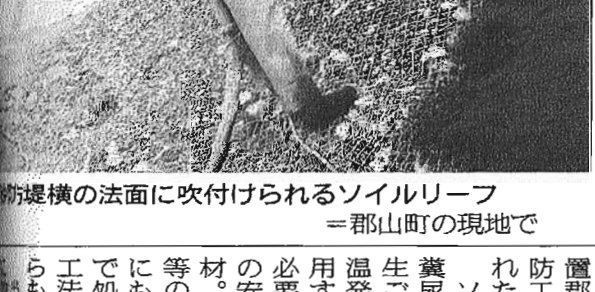
防堤横の法面に吹付けられるソイルリーフ ＝郡山町の現地です
