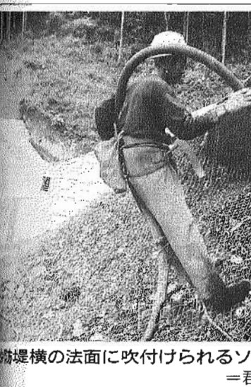
防堤横の法面に吹付けられるソイルリーフ ＝郡山町の現地で
