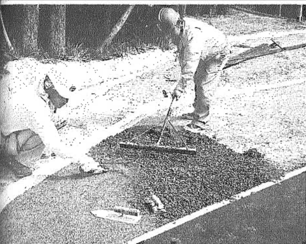
ＪＣ・スーパーパウダーで舗装する作業員 ＝東市来町の現場で
