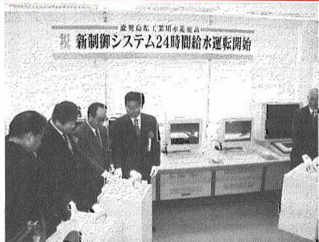
システム稼働のスイッチを押す関係者 ＝鹿児島市の県工業用水道部施設内
