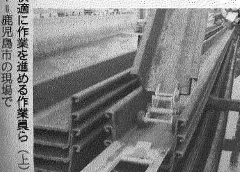
パイラステージ上で安全・快適に作業を進める作業員ら（上）と不快な金属音を防止するパイロローラー＝鹿児島市の現場で
