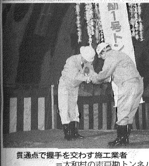
貫通点で握手を交わす施工業者＝大和村の志戸勘トンネル坑内で
