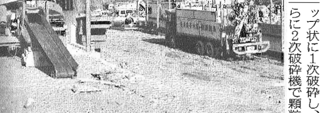
1次破砕機(左)、攪拌発酵槽＝東市来町養母で
