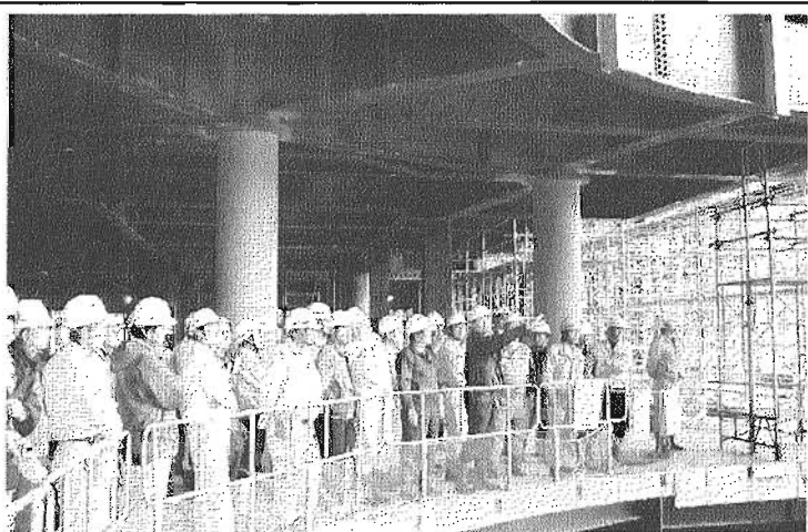
躯体工事の説明に聴き入る会員 ＝鹿児島市の県民交流センター建設現場で
