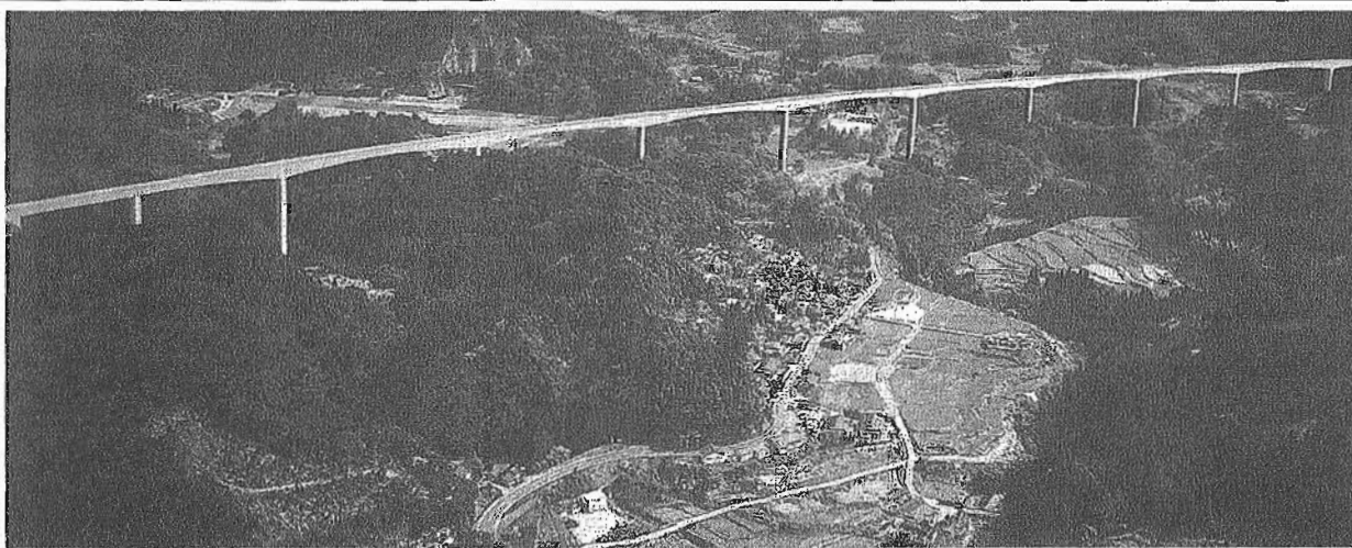
継ぎ目を設けない構造として国内最大の国分川原橋(全長1,146m)＝国分市川原
