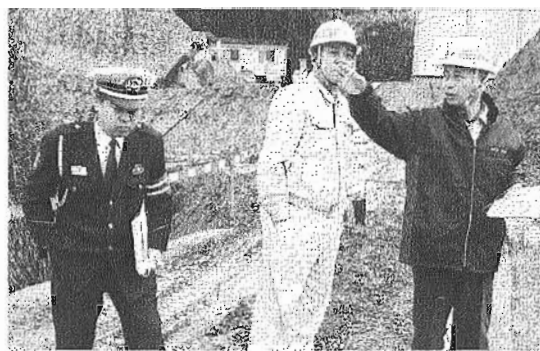
重点項目を点検する診断員ら ＝鹿児島市郡山地区の現場で
