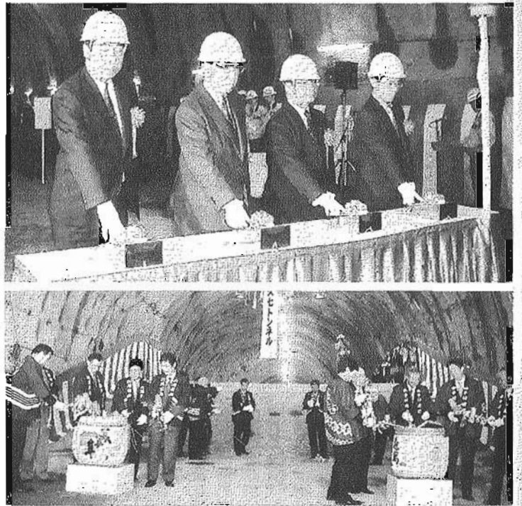
貫通スイッチを点火する直江県土木部長(左)らと貫通を祝い盛大に鏡開きを行う関係者ら(下)＝大口市の久七トンネル工事現場で
