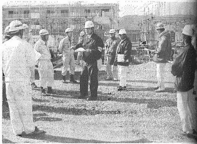
施工状況の説明を行う現場代理人 ＝知覧町の現場で
