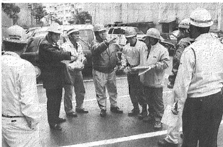
診断を前に確認などを行うパト一行 ＝鹿児島市の武岡住宅外壁改修の現場で
