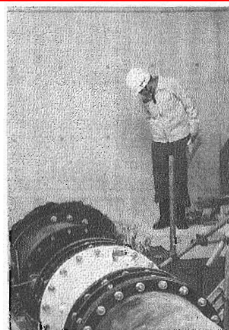
年度末まで無災害を——と呼びかけた安全パトロール＝鹿児島市下水道工事現場で
