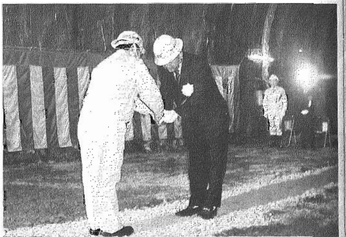
トンネルの貫通を祝いがっちり握手する竹山社長(左)と福永社長＝宇検村の生勝トンネル坑内で
