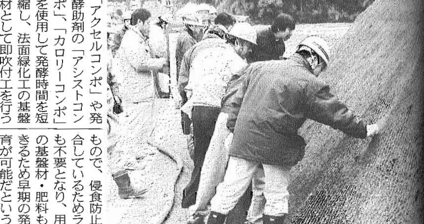
吹き付けられた基盤材に実際に触れて確認する参加者＝栗野町の現地で
