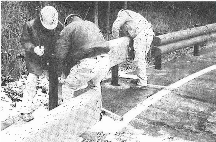
2種類の木製ガードレールを設置する会員ら ＝郡山町の現地で
