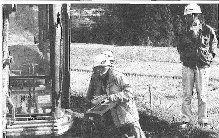
重機の点検も念入りに行ったパト ＝蒲生町の現場で
