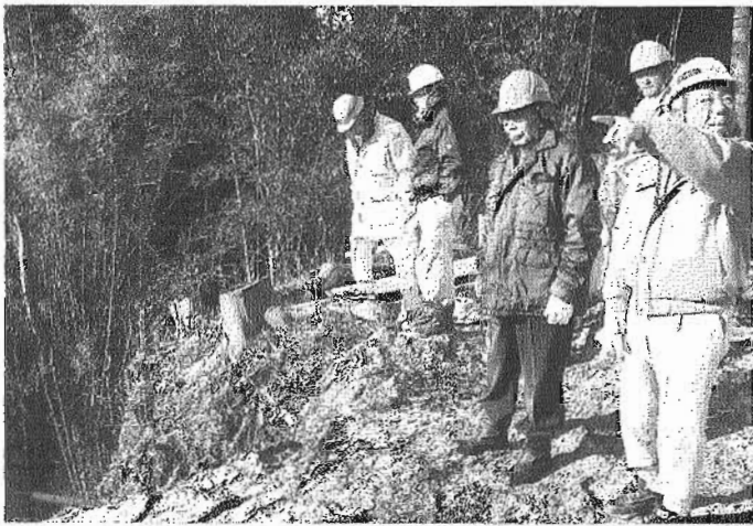
現場の管理状況を見渡すパト一行 ＝鹿児島市の現地で
