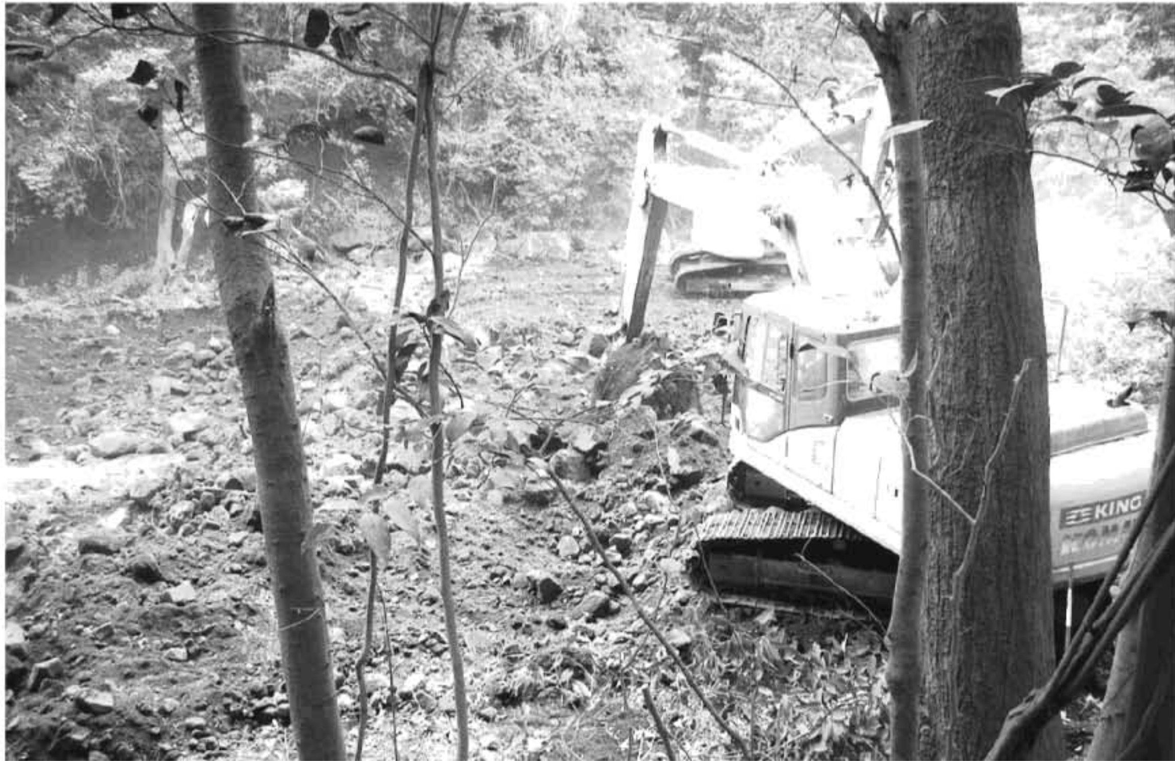
既設砂防堰堤の除石工事 (提供・九州地方整備局)
