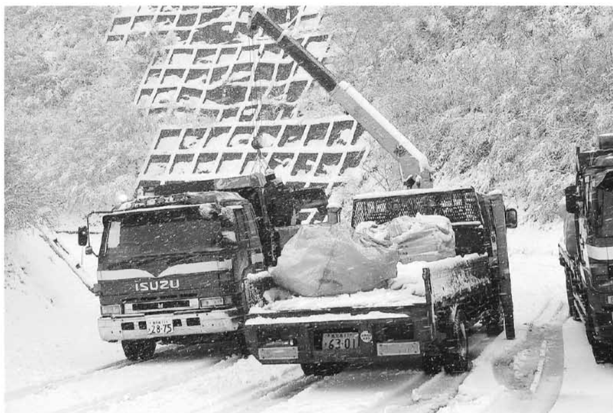
懸命に除雪作業を行う県建設業協会会員 ＝南九州市の川辺峠付近で
