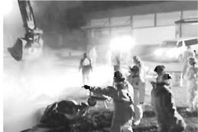
山口県の種鶏場では死亡した鳥から29日に陽性反応を確認、30日に農林水産省からの連絡を受け、県は建協加治木支部へ協力を要請。会員の末重建設(株)(末重堅司社長)より人員3人および0.7㎡バックホウが出動した。同日は午後2時ごろ現地入りし、始良家畜保健衛生所の職員らとともに作業を開始。バックホウを使って縦4m、横4m、深さ3mの穴を掘り、石灰を何重にもまきながら嚴重に埋却処分。午後7時30分までに作業を終えた。
