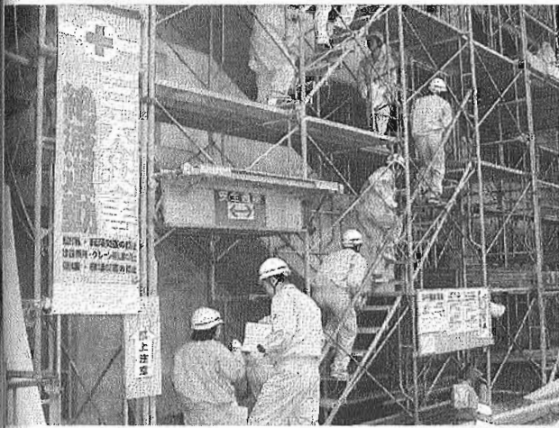
組まれた外階段を上る高校生ら =瀬戸内町の県営住宅新築現場で
