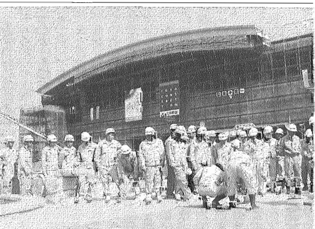
現場研修する高校生 ＝川内市の川内駅西口現場で
