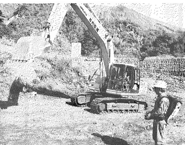
遠隔操作でバックホウを操作するオペレーター＝鹿児島市の現場で
