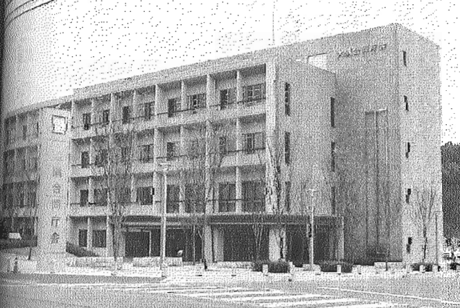
利用者の利便性向上を目的に建設された大隅合庁 ＝大隅町岩川の現地で
