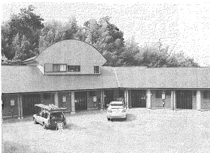
吹上町に完成した熟年共生住宅
