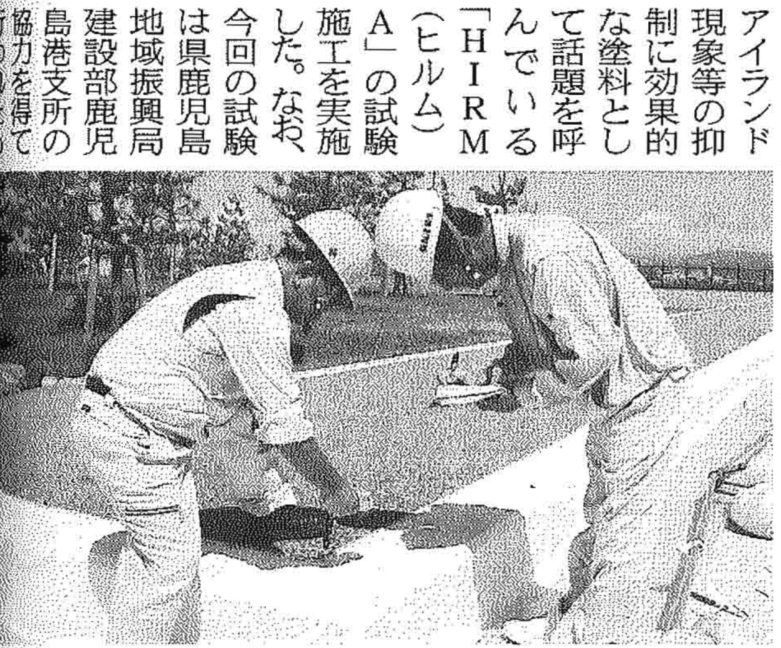
鹿児島市のマリンポートかしまで、ヒートアイランド現象等の抑制に効果的な塗料として話題を呼んでいる「HIRM（ヒルム）A」の試験施工を実施した。なか
