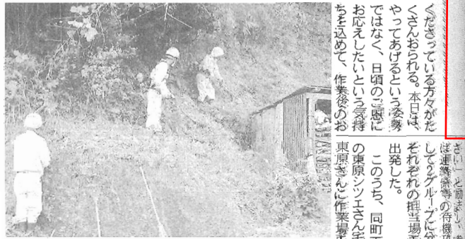
手順良く作業を進める参加者 ＝横川町の現場で
