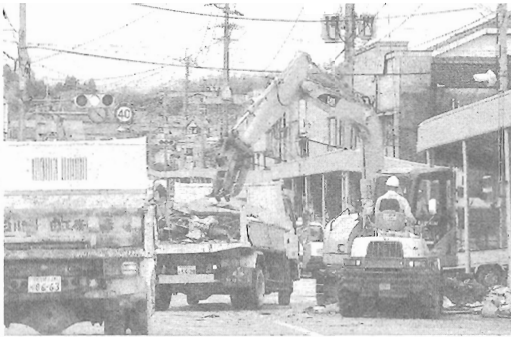
被災地で復旧に取り組み建設業 =さつま町虎居地区の商店街で
