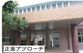
正面アプローチ
